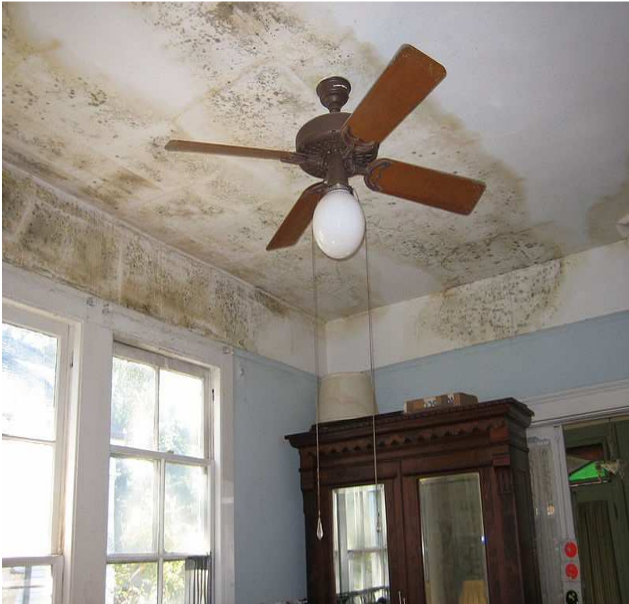
Luchtverwarming in een niet geïsoleerd huis creëert ideale omstandigheden voor schimmel. Wikipedia Commons.
